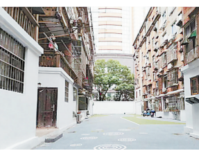
改造后的小区。
