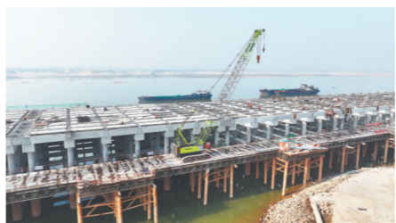
姚湾综合码头建设已完成码头泊位主体结构浇筑,正在进行多用途泊位上部结构施工。
