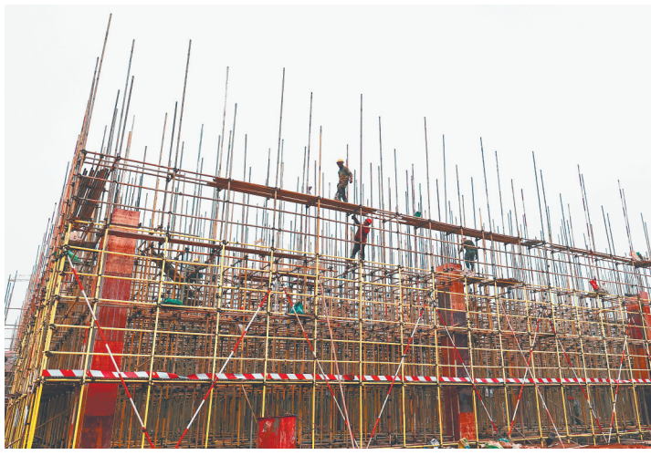
2月7日,在抚州东临新区新型建材产业园区标准化厂房建设现场,施工方正快马加鞭抓生产,全速刷新“进度条”。 (本报全媒体记者 吴文兵 摄)
