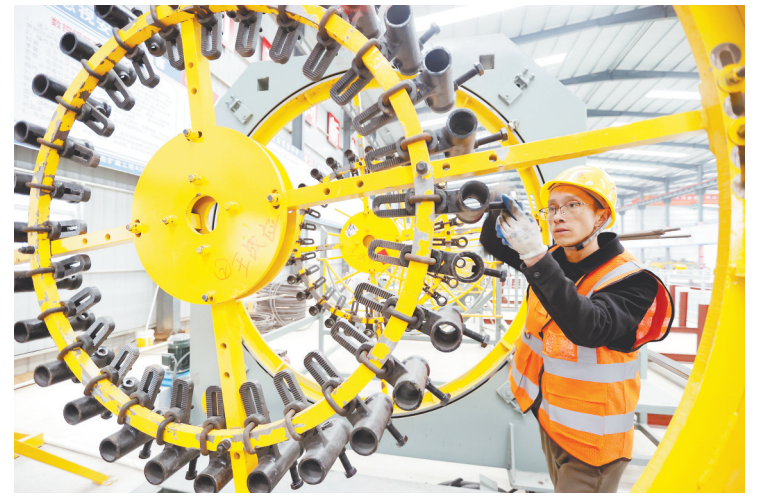
2月13日,位于峡江县戈坪乡的樟吉高速改扩建项目建设工地,工人正在加紧施工。 (特约通讯员 陈福平 摄)
