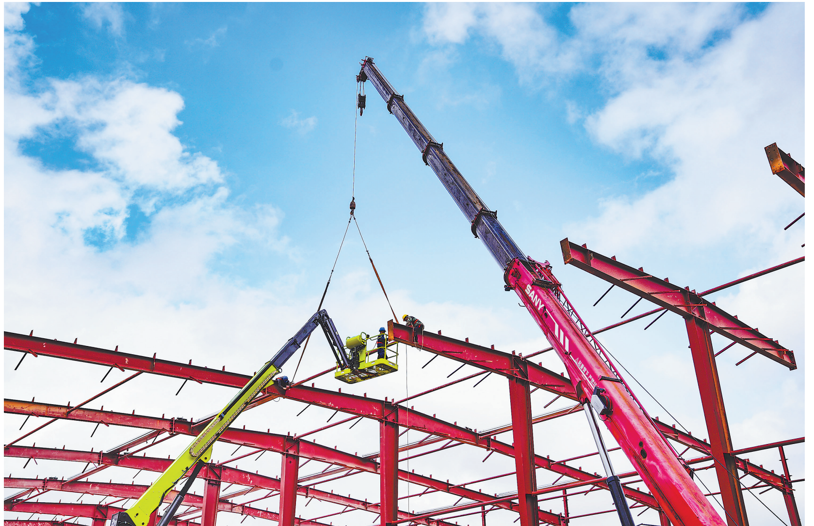
2月12日,位于定南工业园区的废旧锂电池梯次再生利用项目建设现场,施工人员铆足干劲,全力推进项目建设。 (本报全媒体记者 史港泽 摄)
