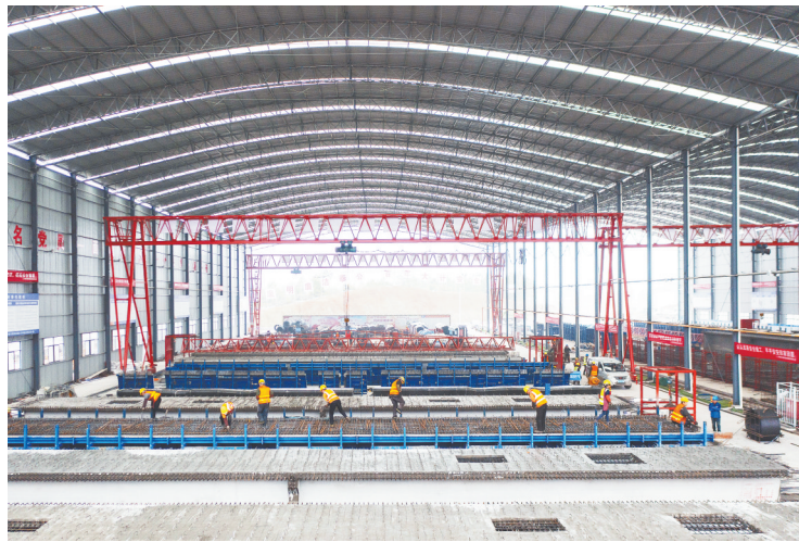
2月7日,在抚州东临环城高速公路工程施工现场,施工班组人员正在浇筑预制箱梁。 (本报全媒体记者 吴福清 摄)
