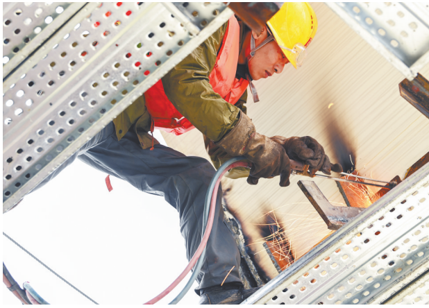
2月9日,在赣州蓉江新区平安大桥建设工程现场,工人冒着细雨进行钢桁梁吊装和焊接作业。 (本报全媒体记者 李劼 摄)
