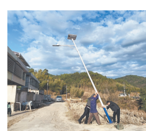
工作人员在安装路灯。
