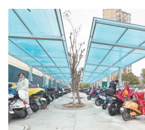
新增的电动车停车棚。
