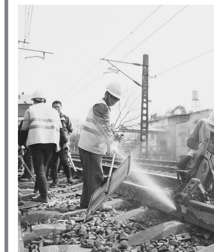
铁路工人在锯轨。
