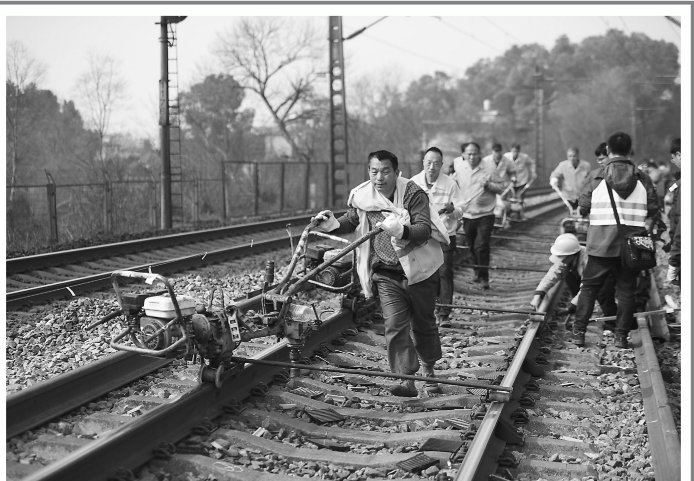
工人在移动螺栓紧固机。
