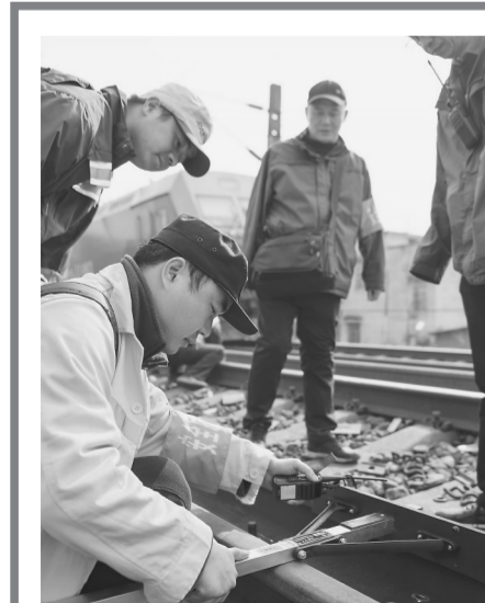
工人使用铁路方尺给轨道定位。
