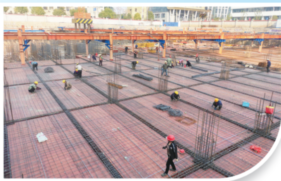
凤凰集贸市场升级改造项目施工现场 刘文摄
