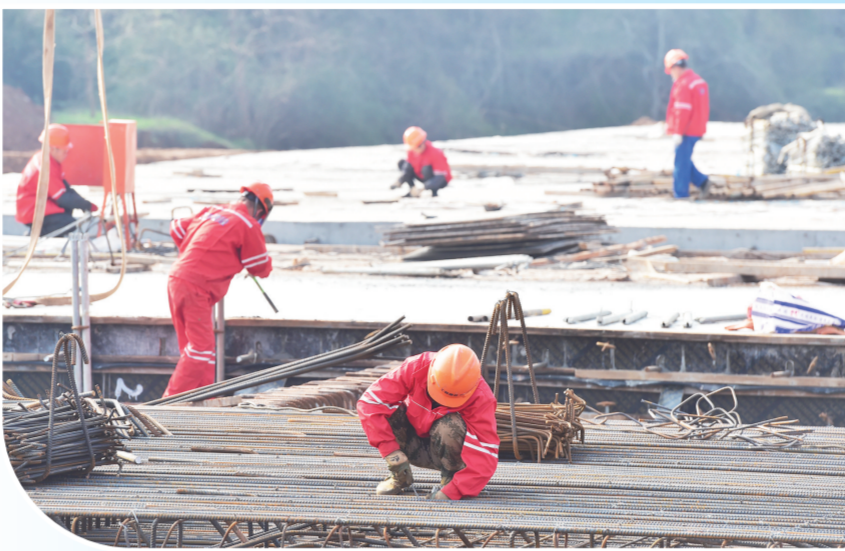
复兴大道西延工程施工现场 喻云亮摄
