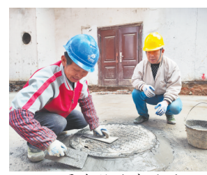
施工人员在维修窨井盖。 本报全媒体记者 洪峰摄
