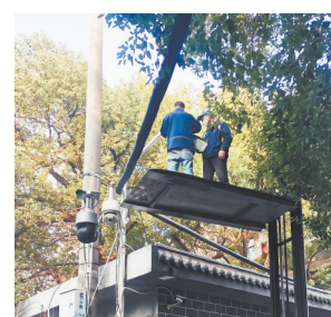
工作人员在更换路灯。 本报全媒体记者 陈璋摄
