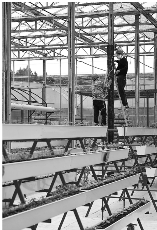
3月25日，在位于赣江新区神农岭本草科技园的中医药“百草园”里，工人正在对智能玻璃温室内部进行升级改造。温室利用物联网技术，可让园内127种不同习性的中草药在同一个温室生长。 本报全媒体记者 郑莹摄
