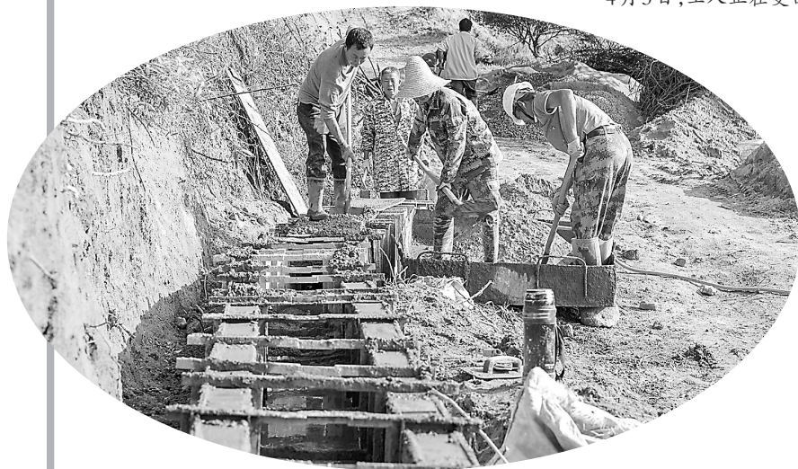
4月1日,南丰县农田灌溉排水渠修建现场,工人们正抢抓晴好天气,开展农田水利基础设施建设。特约通讯员 袁智摄
