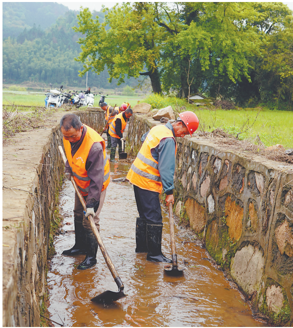
“水管家”正在清理干渠。本报全媒体记者 沈秋平摄
