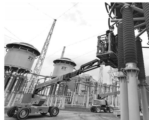
4月20日,位于抚州市东乡区的国家电网雅中—江西±800千伏特高压鄱阳湖换流站,工作人员正在检修设备。夏季即将来临,在用电高峰开始之前,工作人员抢抓时机对设备、线路等进行精益化年度检修,确保特高压电网持续安全稳定运行。
