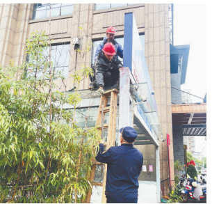
拆除“豪迈”汽修厂的招牌。 本报全媒体记者 蔡颖辉摄
