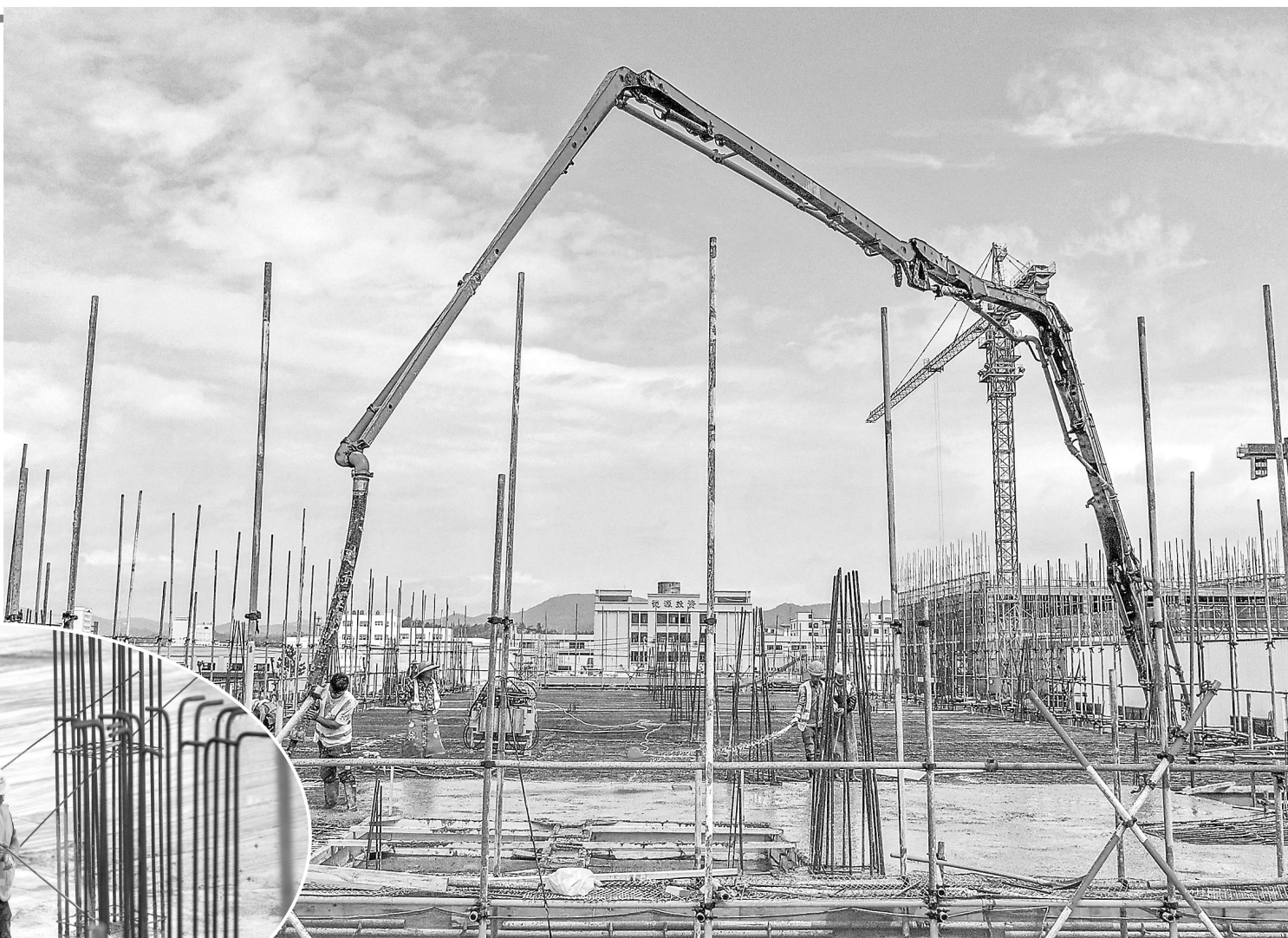
5月3日,在定南县富田工业园区定南和美实业年产2.5万吨新型高分子材料项目建设现场,工人们忙着扎钢筋、搭建模板、浇筑混凝土,抢工期、赶进度,全力推进项目建设。 本报全媒体记者 史浩洋摄
