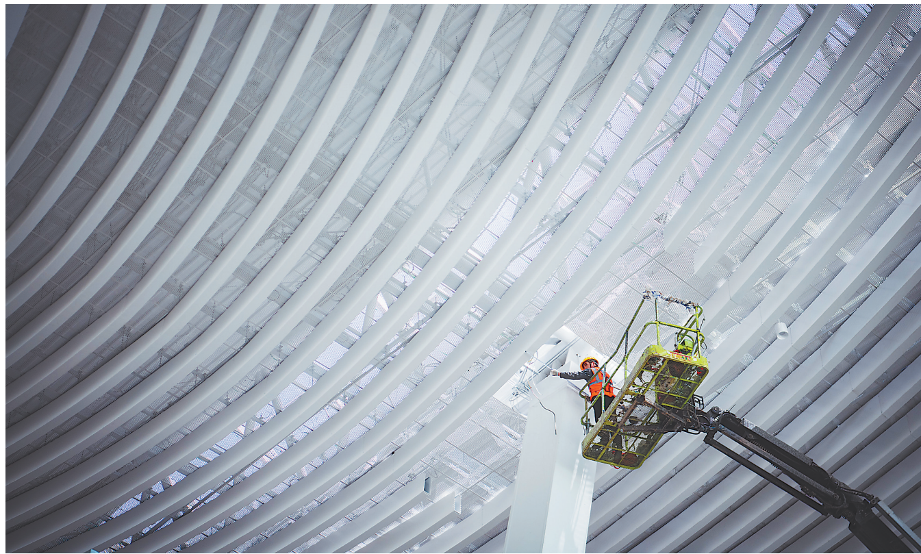
5月1日，在中建三局承建的武汉天河机场T2航站楼改造工程项目工地，工人检查吊顶内管线。新华社记者 伍志尊摄
