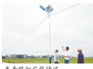
查看路灯安装情况。 通讯员 李嘉勋摄
