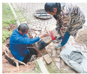
施工人员在修复井盖。
