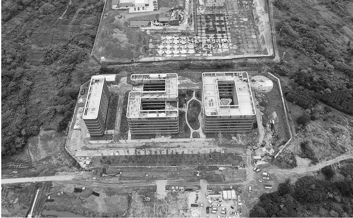
5月23日，在南昌市红谷滩区九龙湖片区的南昌新急救中心项目施工现场，以“1”“2”“0”三个生命急救电话数字为设计主题的三栋大楼，主体结构已封顶。目前，该项目进入施工收尾阶段，建成后将承担南昌市日常院前医疗急救、重大灾害事故救援、社会活动医疗保障等工作。
