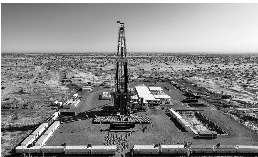
5月30日拍摄的“深地塔科1井”(无人机照片)。新华社记者 李响摄
