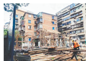
危房拆除现场。
