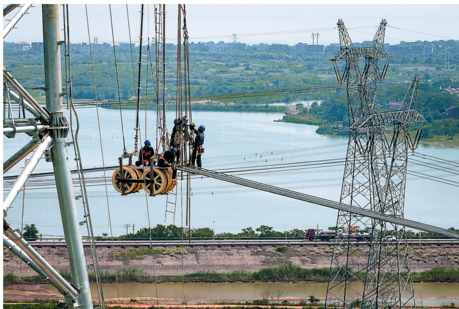
6月2日，在进贤县三阳乡附近的武汉至南昌1000千伏特高压交流输电线路工程（江西段）施工现场，电力工人正在近百米高的铁塔上进行跨越湖导线展放作业。该工程是我省第三个特高压工程，投运后将有助于进一步加强华中地区电力互联互通，优化能源结构，为经济高质量发展提供清洁绿色能源和强大电力支撑。
