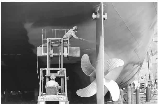
6月8日，湖口高新技术产业园区内的华东船业造船厂生产有序，工人正对即将交付的船只喷漆扫尾作业。特约通讯员 张玉摄
