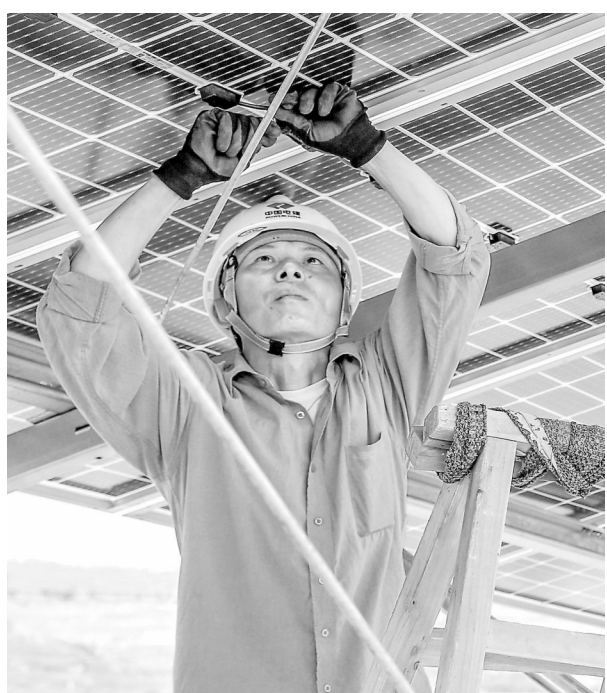
6月9日,位于南丰县菜溪乡的阜阳西山180兆瓦农(林)光互补光伏电站项目建设现场,工人正在加紧作业。近年来,南丰县积极推进光伏项目建设,壮大村集体经济,促进农民增收。 本报全媒体记者 徐立鸣摄
