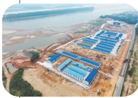
塔城枢纽正在建设中
