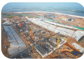
赣江主支加紧建设中
