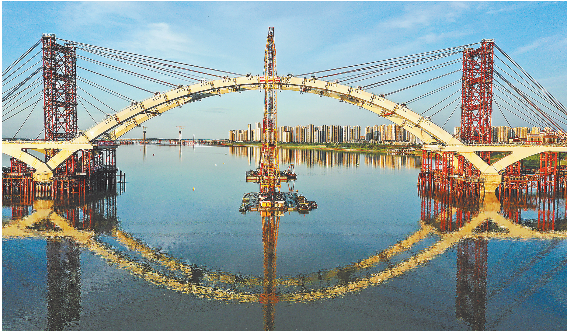
6月28日,南昌复兴大桥中跨主拱顺利合龙,标志着项目建设进入新阶段,为今年10月主梁合龙打下坚实基础。复兴大桥是南昌市第八座跨赣江桥梁,是我省最大跨度的钢混组合梁钢箱拱桥,也是国内叠合板组合梁桥面最宽的拱桥。大桥建成后,将完善南昌市“一江两岸”快速交通体系,为南昌都市圈一体化发展提供有力支撑。 本报全媒体记者 史港泽摄
