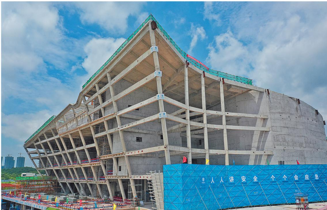
6月27日，航拍南昌保利大剧院项目施工现场，“游弋之鱼”的概念外形已初步呈现。目前，保利大剧院项目主体已全面完成施工，正在进行机电设备安装和幕墙施工，预计2025年4月对外营业，建成后能满足歌舞剧、音乐剧、戏曲、话剧等各类演出，进一步丰富市民的文化生活。
