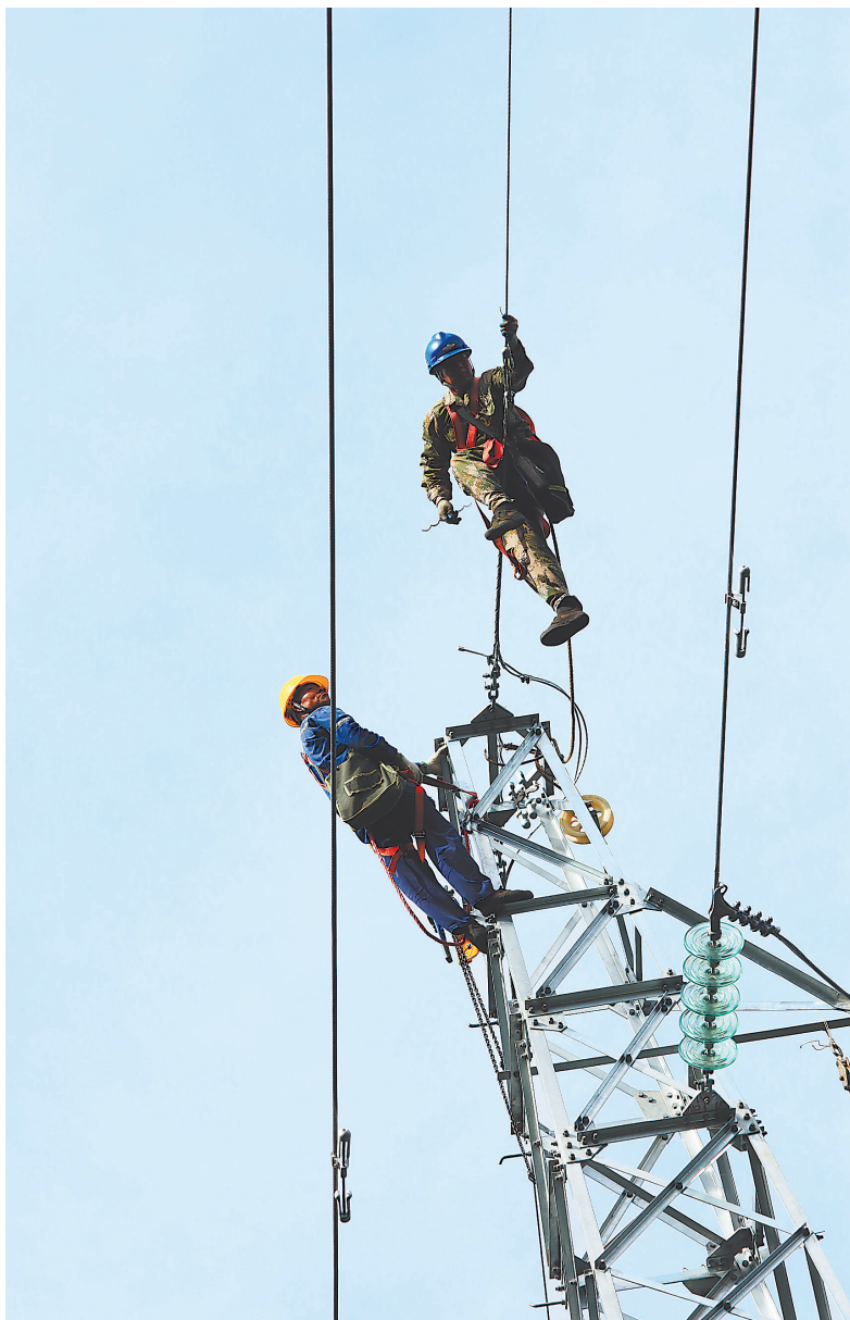
7月3日,在乐安县金竹畲族乡,电力工人冒着高温在35千伏新建线路施工现场高空作业,保障电网供电安全。 特约通讯员 邱志超摄
