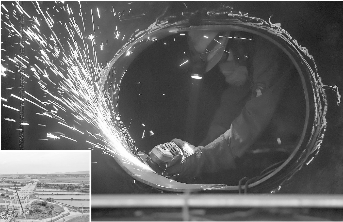
▲7月4日,湖口高新技术产业园区内的萧恒钢构有限公司桥梁构件生产厂区,工人正在赶制订单。正值夏季高温天气,湖口县强化调度,施工单位科学组织施工,实行早晨早上班、中午早下班的工作方式,确保工人避暑和施工进度两不误。
