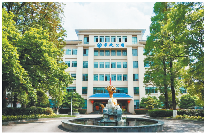
赣州市政公用集团总部办公楼
