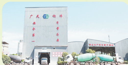
上饶广天建筑构件有限公司是上饶市首家预拌混凝土生产资质企业
