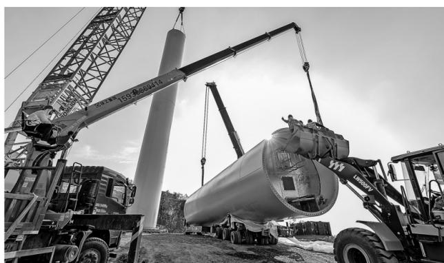
7月11日,瑞昌市横立山风电场项目施工现场,工人正在吊装风电塔筒。近年来,瑞昌市坚持绿色发展理念,利用丰富的风力资源大力发展绿色清洁能源,促进节能降耗、低碳减排,为绿色生态环境改善和乡村振兴注入了新动力。
