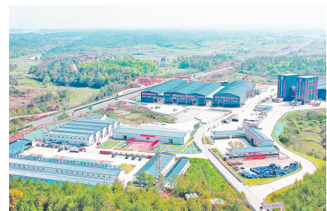
樟吉改扩建项目为沿线村镇修建硬化便道等惠民便民设施
