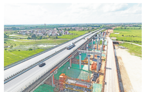
樟吉改扩建项目控制性工程——袁河特大桥正在加紧施工
