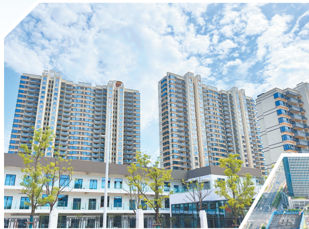
生米丰都(一期)B02地块安置房项目
