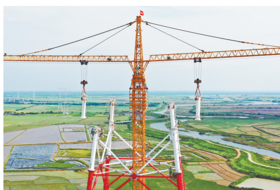
施工人员在百米高空组装塔材。
