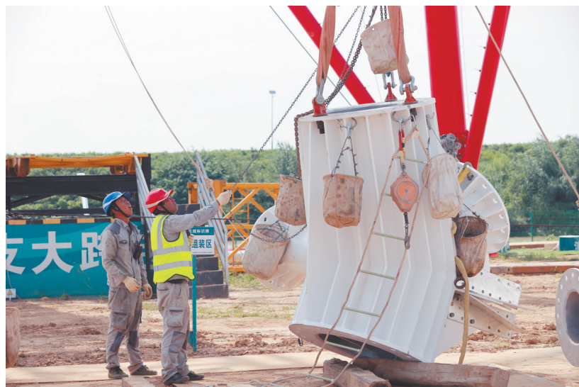
地面施工人员按施工进度准备好相应的塔材。
