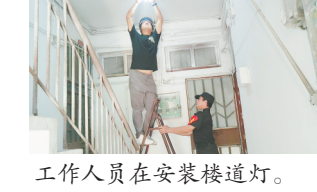
工作人员在安装楼道灯。 本报全媒体记者 蔡颖辉摄
