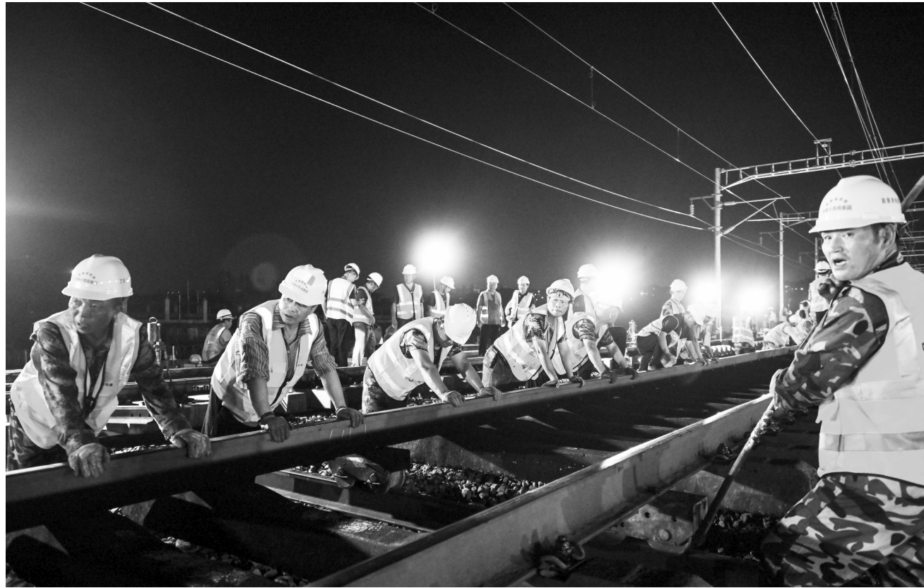
施工现场。 通讯员 鲍赣生摄
