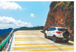
公路安装了减速带和防护栏。
