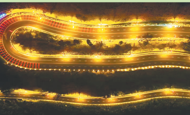
井冈山红色之路智慧提升工程
