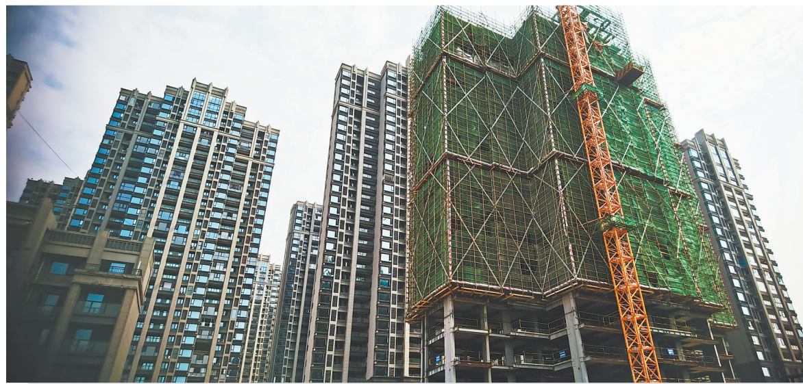
反复停工的城泰枫华天成楼盘一角。
