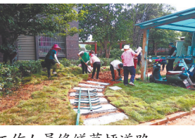
工作人员修缮草坪道路。 本报全媒体记者 陈璋摄
