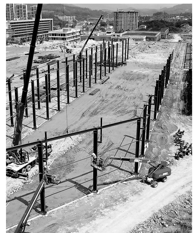
近日,在安远县电商快递物流园项目现场,建设者正安装钢结构仓库,全力推进项目建设。该项目总投资约5亿元,包括中心智能云仓、快递物流分拣中心等设施建设。项目建成后,预计农产品年吞吐量26万吨,有助于进一步健全城乡流通体系,促进产业发展。 本报全媒体记者 焦俊杰摄
