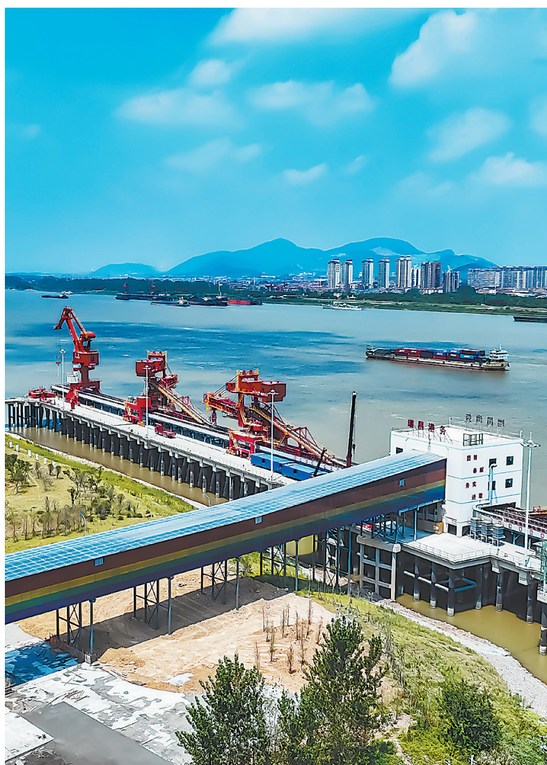
九江港瑞昌港区金丝港作业区码头整合工程日前通过竣工验收,标志着项目进入正式运营阶段,九江港整体新增通过能力3300万吨。图为近日该港作业区码头,船舶在泊位上有序装卸货物。特约通讯员 魏东升摄
