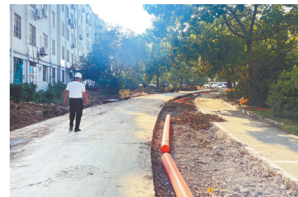
小区挖开的路面。本报全媒体记者 蔡颖辉摄
