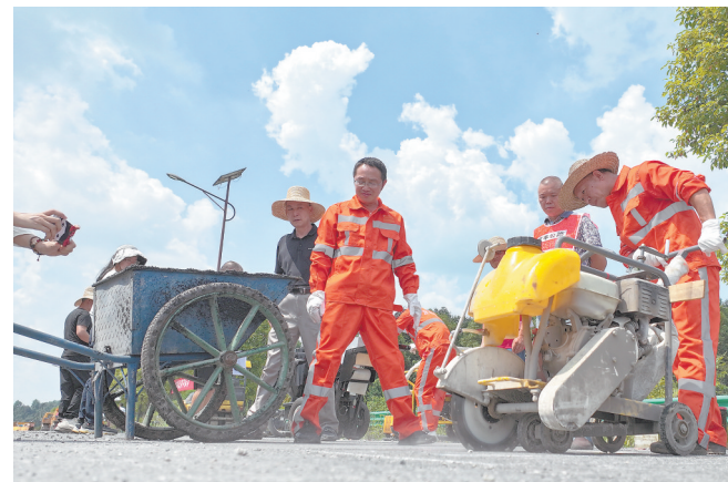
坑槽修补、桥梁安检、理论测试……近日,宜春公路分中心举办养护技能竞赛,以赛促学,提升公路养护工作效能。特约通讯员 何贱来摄
