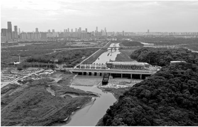
9月12日，南昌市乌沙河泵闸枢纽工程项目施工正酣。该工程位于乌沙河末端与赣江交汇处，是集防洪涝灾害、改善河道水环境、提高城市品位等功能于一体的综合水利枢纽工程，目前已经进入收尾阶段，预计10月完工。本报全媒体记者 洪子波摄
