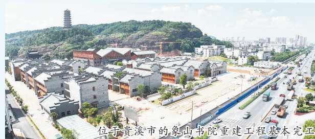
位于贵溪市的象山书院重建工程基本完工
