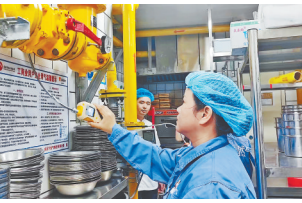
工作人员在检查燃气管道。 易永艳摄
