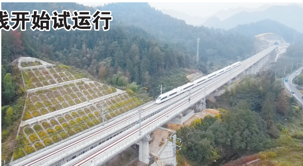
10月26日,试运行列车行驶在昌景黄高铁线上(无人机照片)。新华社记者 周牧摄
