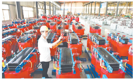
赣电电气有限公司员工正在吊装变压器
