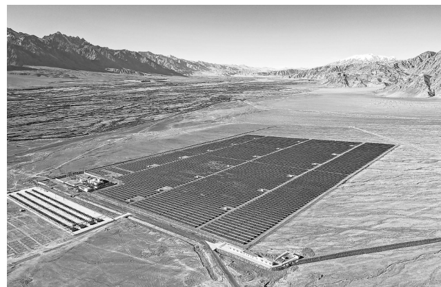
11月5日，无人机航拍的新疆喀什地区塔什库尔干县的深能福塔光伏发电项目。
