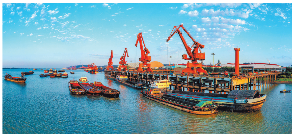
11月7日,位于湖口高新技术产业园区内的方大九钢公司产品码头,工人正在进行成品钢材装车作业。该公司认真贯彻落实习近平总书记考察江西重要讲话精神,通过积极发挥沿江水运优势,做好码头产品发运工作,保障了销售物流快捷、有序。 本报全媒体记者 梁振堂摄
