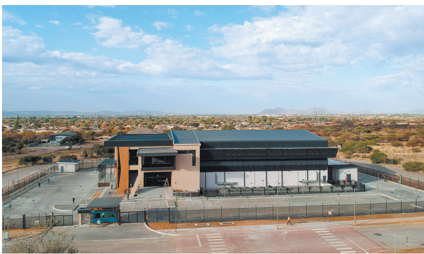
这是2023年8月10日在博茨瓦纳首都哈博罗内拍摄的正在建设的博茨瓦纳国家数据中心。由中国江西国际经济技术合作公司博茨瓦纳分公司承建的博茨瓦纳国家数据中心项目位于哈博罗内科技园区，预计今年年底竣工验收。 新华社发（中国江西国际经济技术合作公司博茨瓦纳分公司供图）
